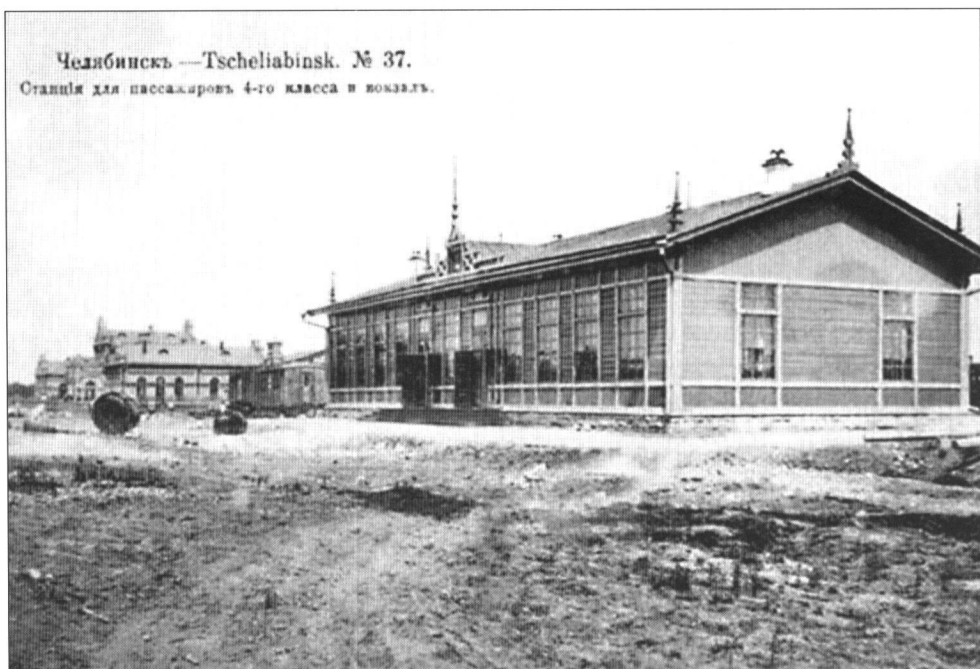
Фото № 20. Вокзал. Станция Челябинск (слева) и здание барачного типа для пассажиров 4-го класса (справа)
