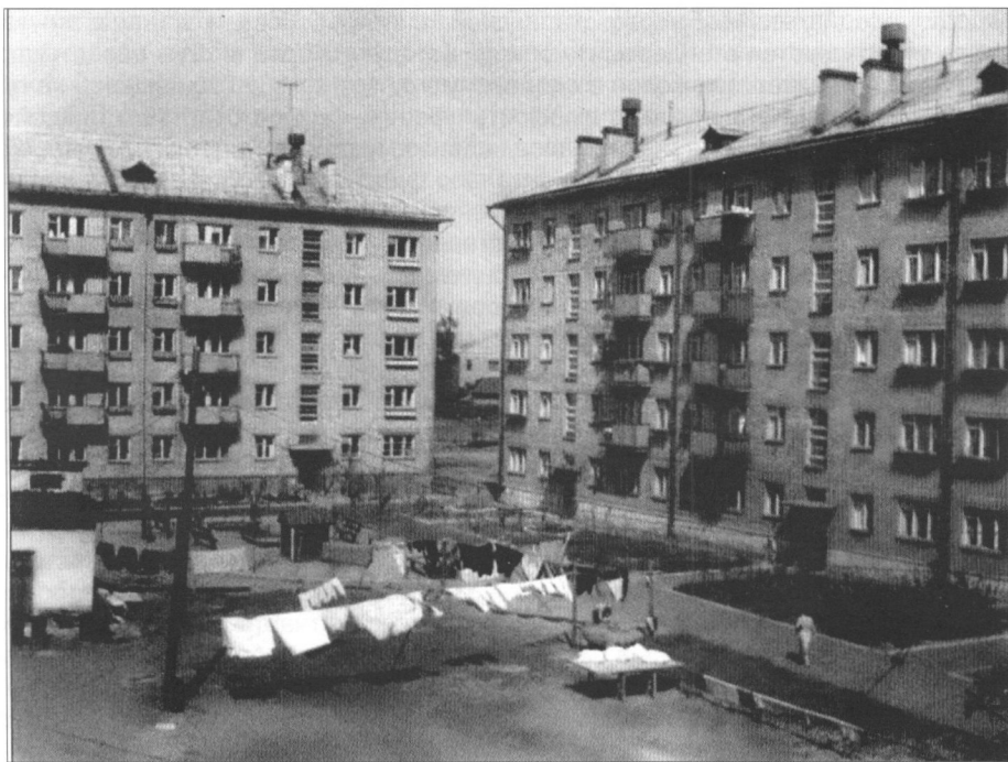
«Хрущевки» в Ярославле, 1950-е гг. Сюда переезжали из коммуналок и барачков
